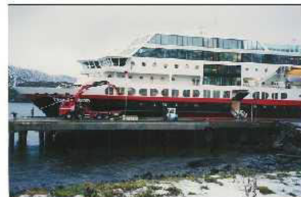
Slutføring av arbeidet med forlenget kai. MS Trollfjord november 2002.
